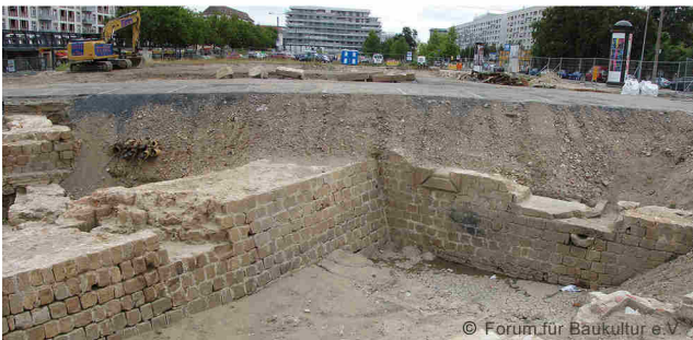
So. 04.09.2016 Grabungsbereich Nord Postplatz / Wallstrasse (Blick von Norden)
